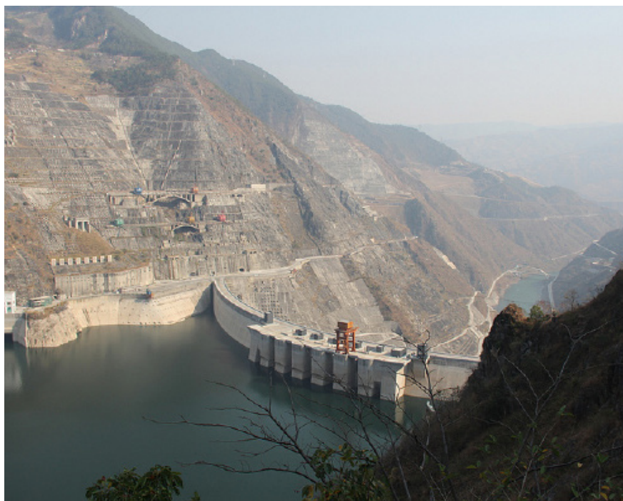
澜沧江上的小湾水电站于2010年完工，是世界上最高的大坝之一。
